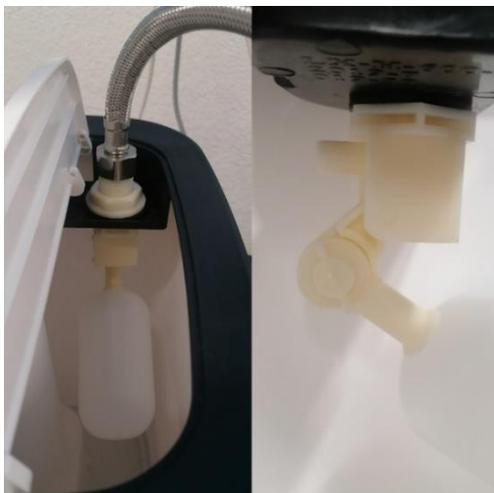
Den Schwimmer setzt man von unten in das Loch im schwarzen Rahmen (welcher sich oberhalb des grossen Wasserbehälters befindet) ein, so dass der Schwimmer genügend Platz hat, um sich zu bewegen von oben bis ganz nach unten und zieht dann die helle Kunststoffmutter am Gewinde von oben her fest. Danach können Sie nur noch den silbernen Schlauch auf das Gewinde schrauben mit Hilfe des gelben Schraubutensils.
